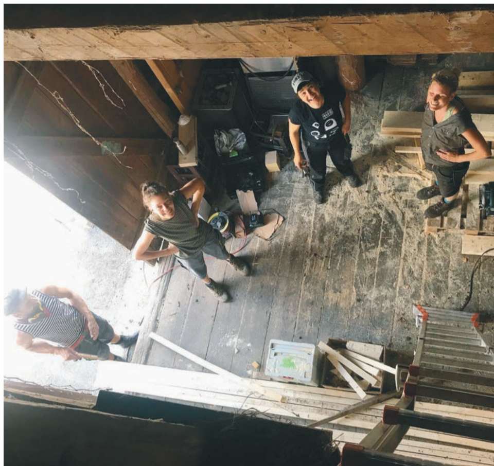
Avec le chantier du toit, le collectif GemSe se prépare aux hivers à venir.
