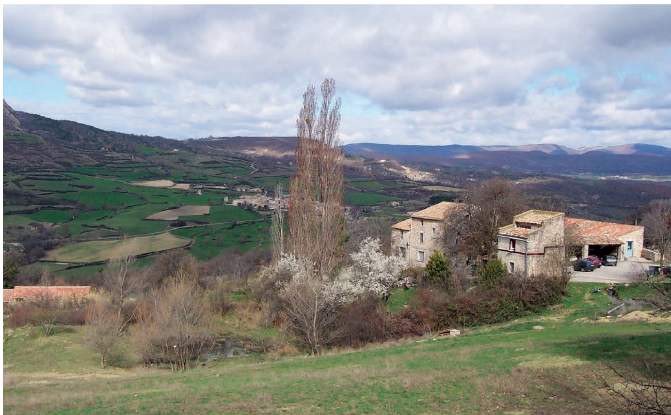
La future retenue d'eau du Pigeonnier va trouver sa place dans la cavité naturelle devant la ferme
